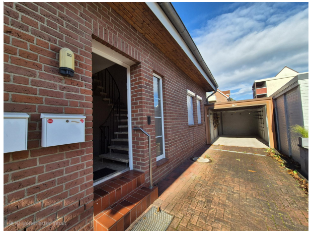
Eingangsbereich mit Garage
