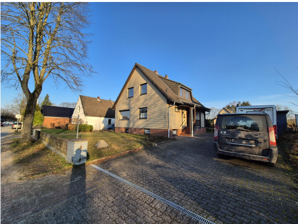
Hausansicht von der Straße aus
