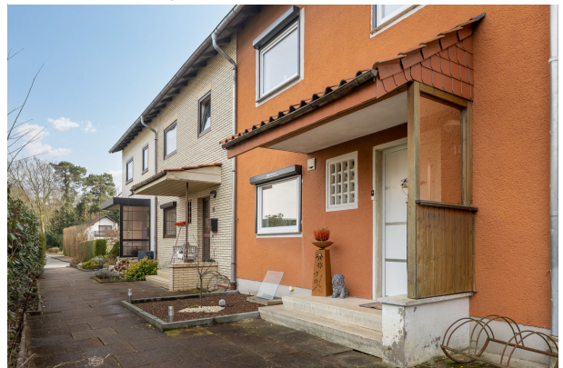
Ansicht Richtung Straße
