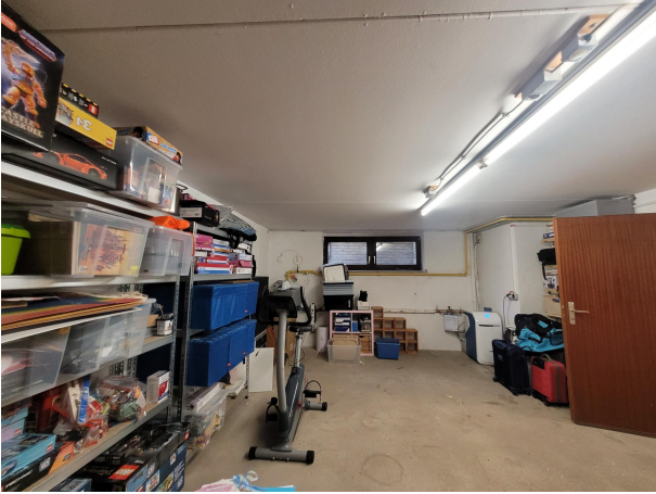
Keller mit Heizung
