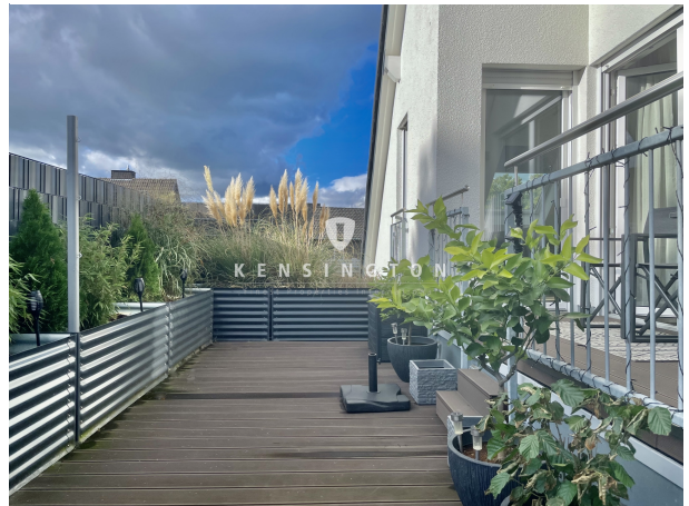
Garagendach mit OG Balkonverbindung
