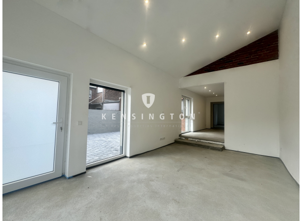
EG Anbau Blick zur Küche vom Esstrakt fi
