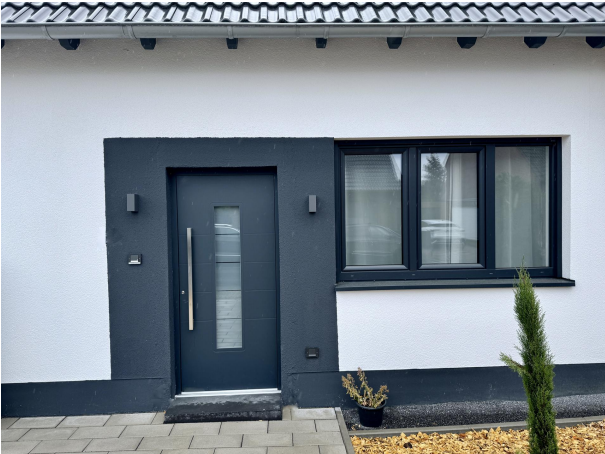
Eingangsbereich einlieger Frontseite
