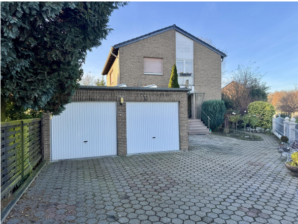
Hof Garage Eingang 2
