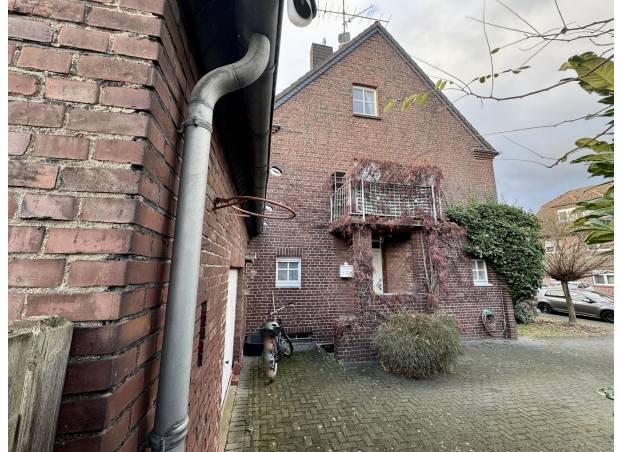
Giebel links Hauseingang mit Hof
