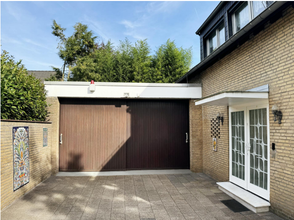
Frontansicht Haus Garage
