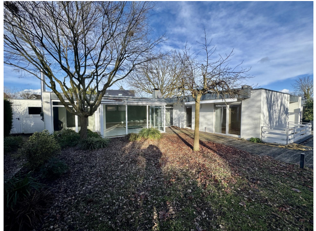
Aussenansicht Hinten ganzes Haus
