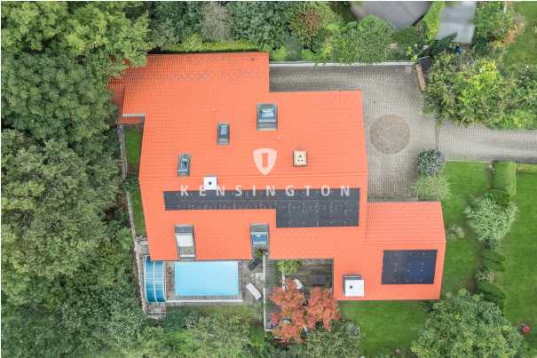
Luftaufnahme mit PV Anlage 5.0
