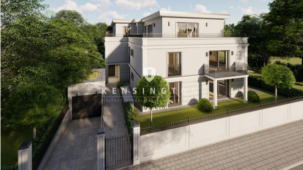
Außenansicht von der Straßenseite
