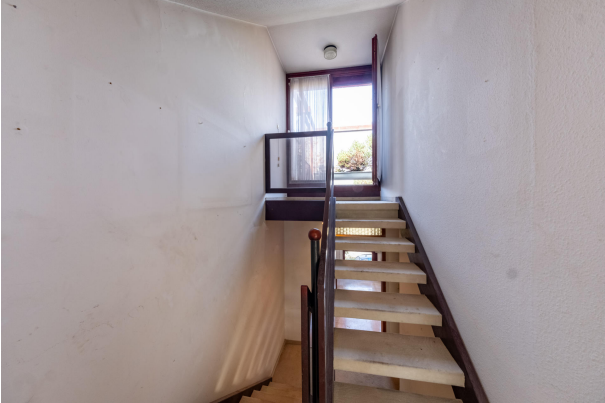
Treppe zum DG
