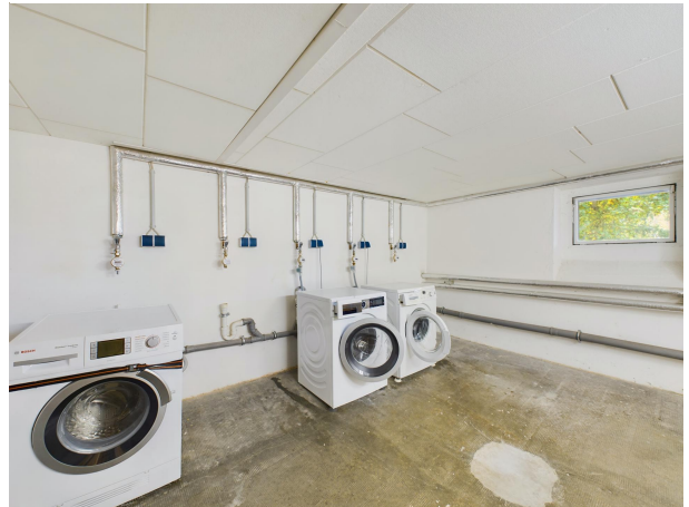
Stellplatz für Waschmaschine und Co.
