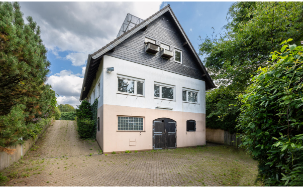
Nebengebäude Rückansicht / Garagen / Pferdeboxen / Ausbaureserve
