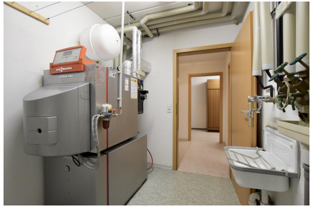
Heizungsraum / Öl-Zentralheizung
