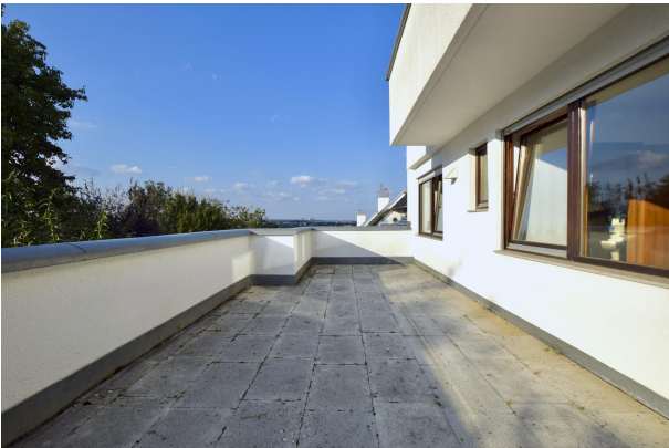
Balkon / Dachterrasse im 1. OG
