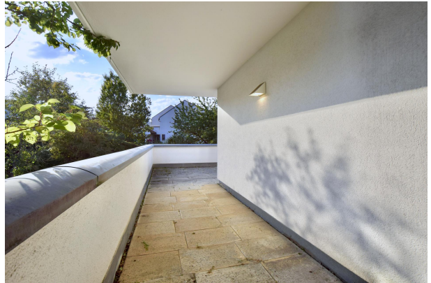
Balkon / Dachterrasse im 1. OG
