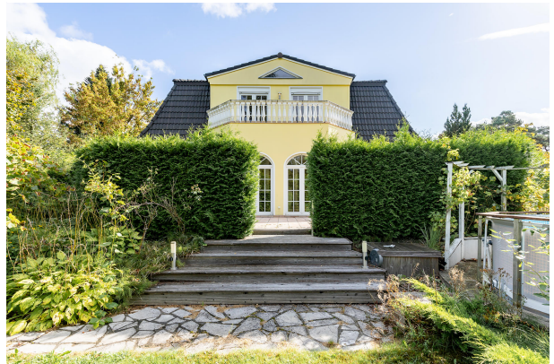
Gartenansicht auf das Haus
