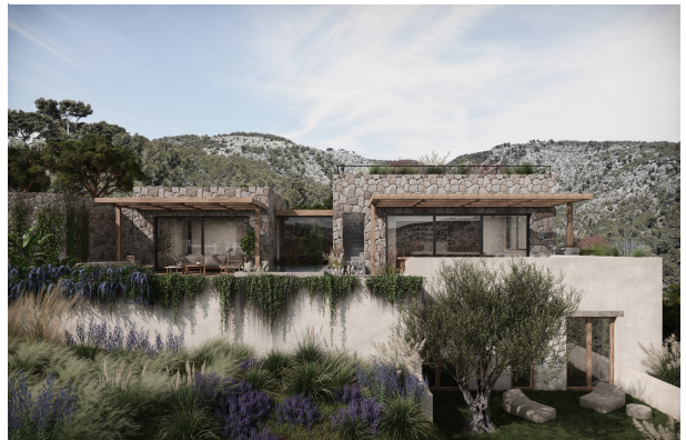
Fassade Moderne Villa Costa d'en Blanes
