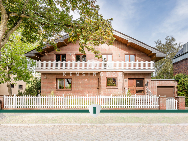
*KBSOK_2320 - Einfamilienhaus in Berlin-Lichtenrade
