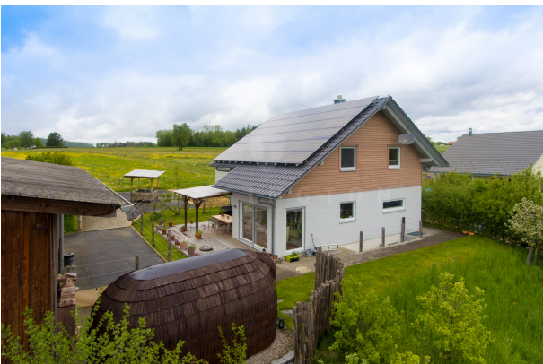
4.5 Zimmer Wohnhaus mit Photovoltaik
