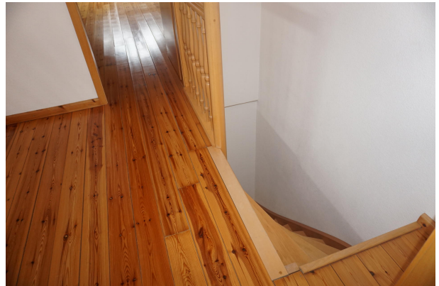
Treppe zum Spitzboden
