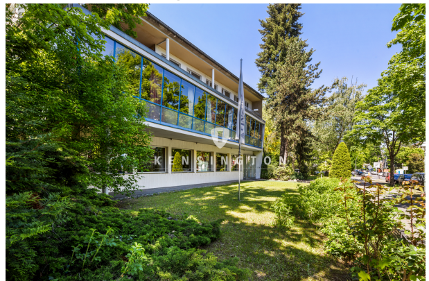
Grundstück mit Abrissgebäude
