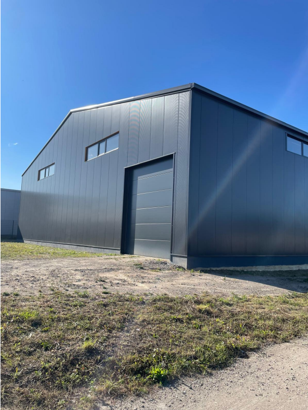
Halle Ansicht Hinten
