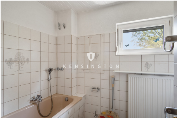
Bad mit Dusche und Wanne
