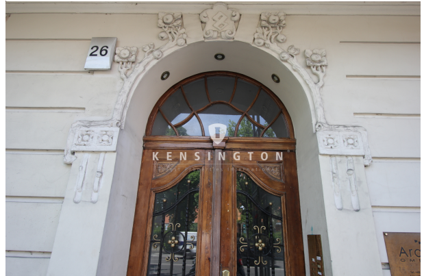
Hauseingang, rechtes Haus
