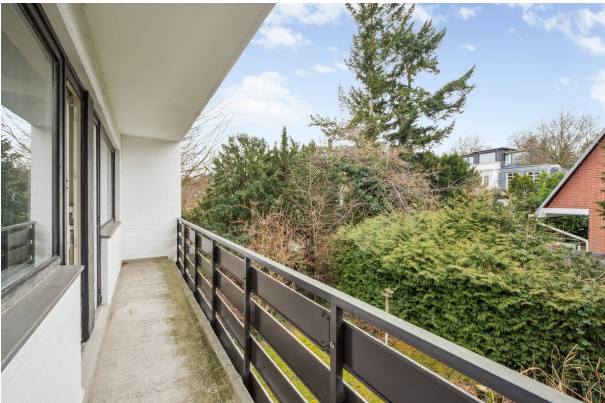
Balkon im 1. OG
