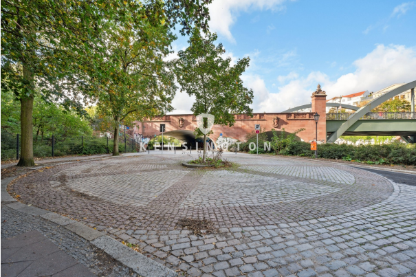
Brücke über die Spree
