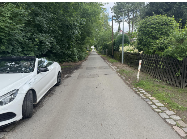
Straße vor dem Grundstück
