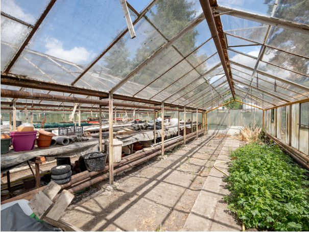
Abrissobjekt / Treibhaus - voll unterkellert
