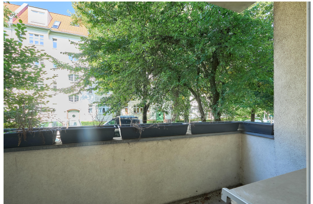
Balkon im Erdgeschoss mit Jalousien
