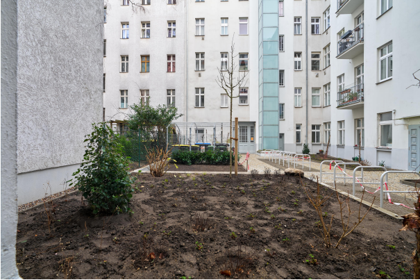
Sanierungsarbeiten gerade im Abschluss
