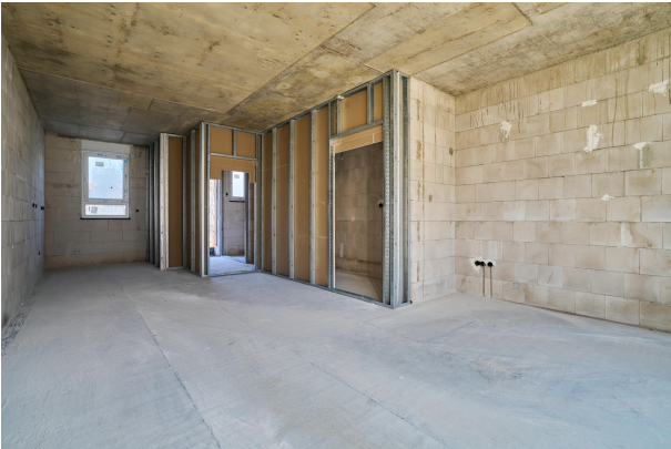
Rohbau Küche und Wohnzimmer
