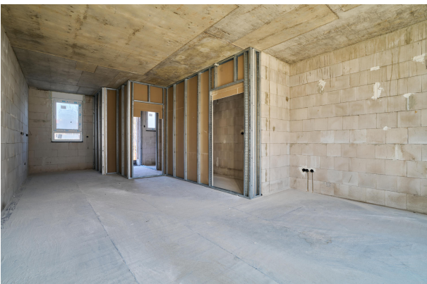
Rohbau Küche und Wohnzimmer
