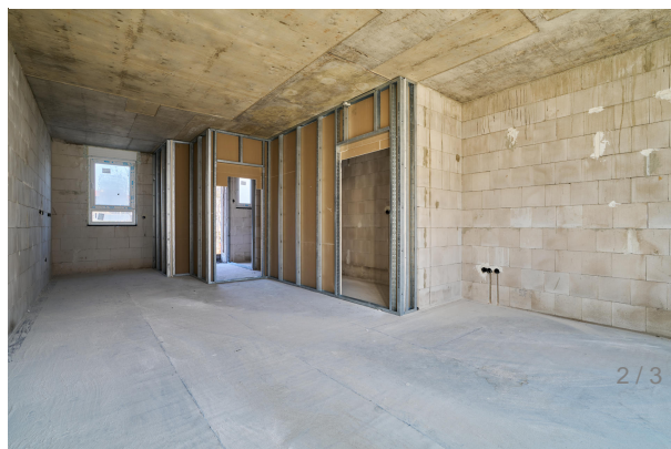
Rohbau Küche und Wohnzimmer
