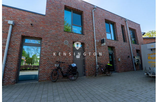
Nord Ansicht Eingang Gästezimmer
