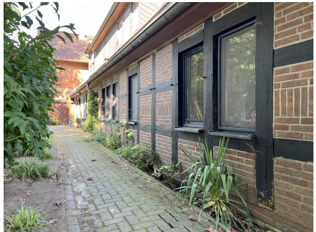
Wohnhaus seidl. Eingangsbereich
