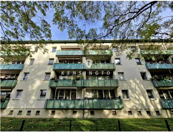
Wohnhaus Südansicht I
