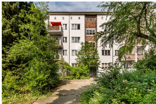
Hof- und Gartenansicht
