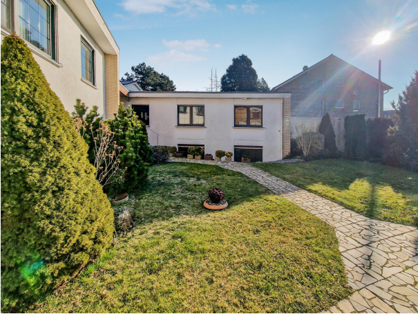
Blick auf Anbau
