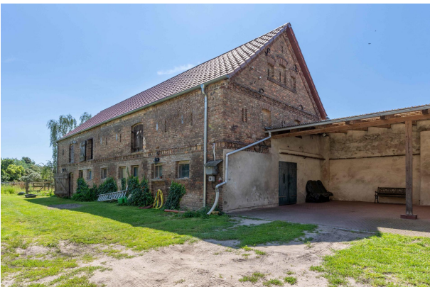
Scheune von vorne
