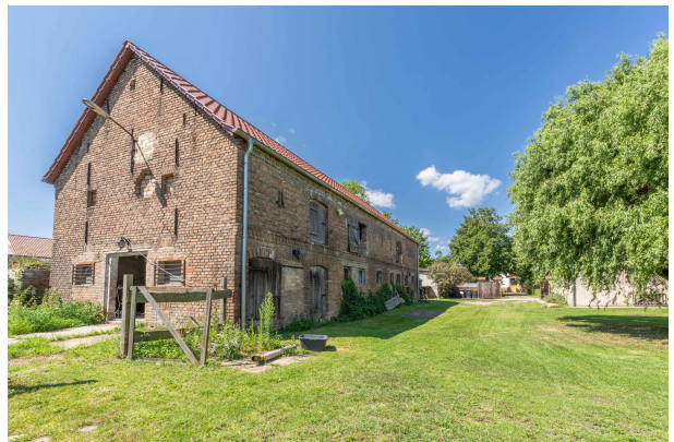
Scheune von hinten
