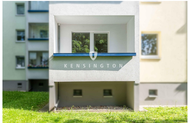
Blick zur Loggia
