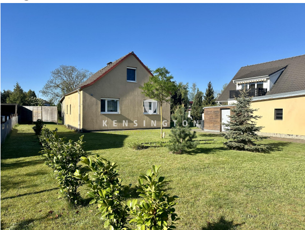
Vorgarten Ansicht Wohnhaus vorn
