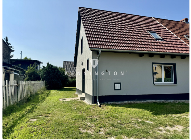
Haus mit Vorgarten von Vorne
