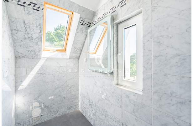
Vorgerüstetes Badezimmer im Dachgeschoss
