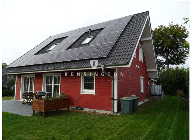
Terrassenseite mit PV-Anlage
