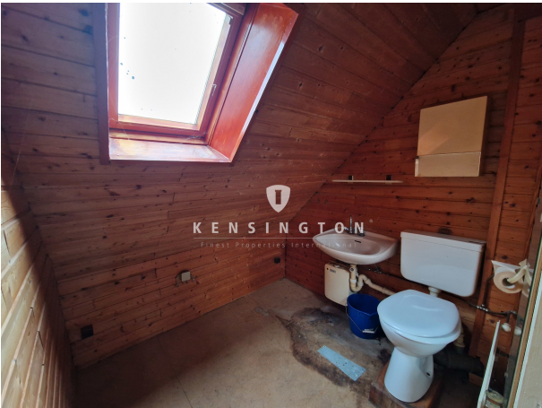
WC auf dem Dachboden
