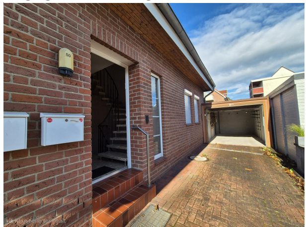
Eingangsbereich mit Garage
