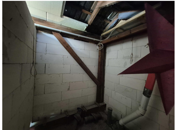
Raum für ein mögliches WC im DG
